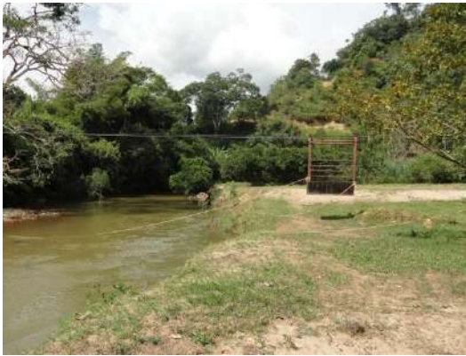
c. Quebrada Guacas – “La Garrucha” *
