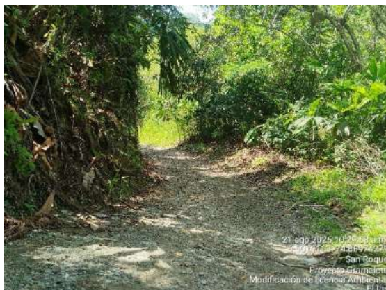
Vía interna, vereda El Iris
