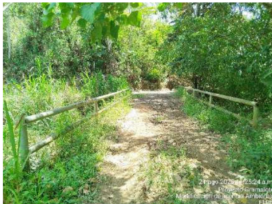
Vía interna, vereda El Iris
