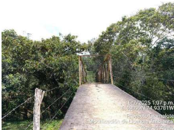
Pontón en vía interna, vereda Guacas Abajo
