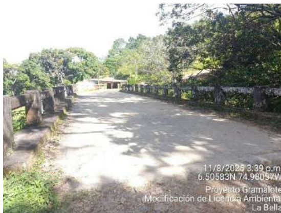
Puente en vía interna, vereda La Bella
