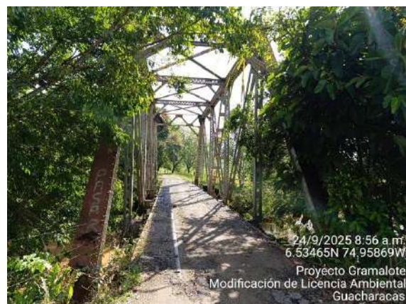
Puente en vía interna, vereda Guacharacas
