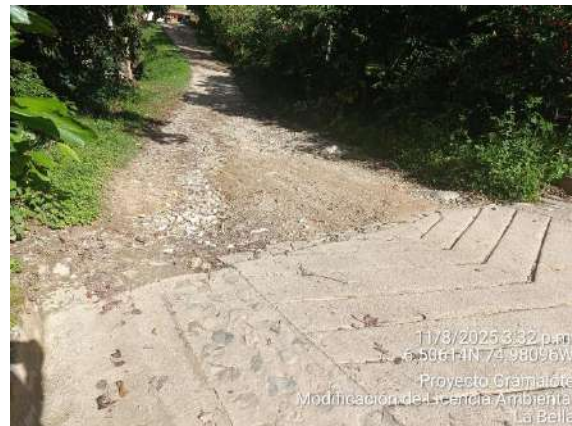
Vía interna, vereda La Bella
