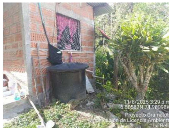
Fotografía 5.3.29 Tanques de almacenamiento y abastecimiento en las viviendas
