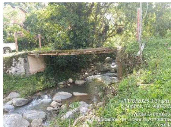
Puente en vía interna, vereda La Bella
