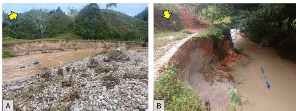
Fotografía 5.5 Socavación de orillas en quebradas tributarias del río Nus. A. Erosión lateral en la margen izquierda de la quebrada Guacas, B. Erosión lateral en la margen derecha de la quebrada El Topacio
