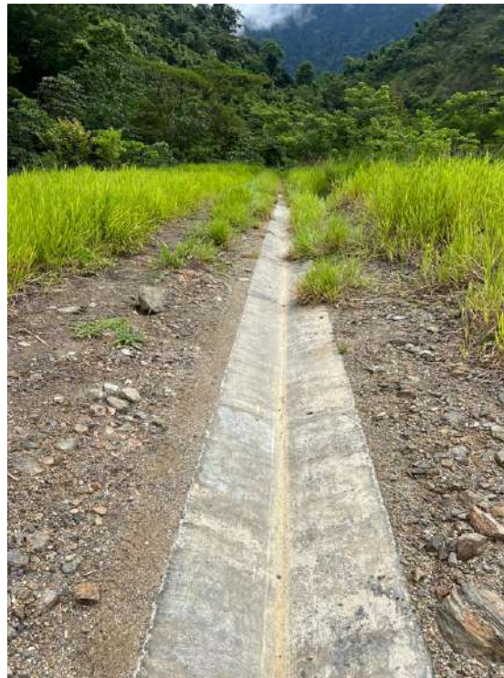
Fotografía 3.17 Cunetas en concreto para las bermas de los depósitos
