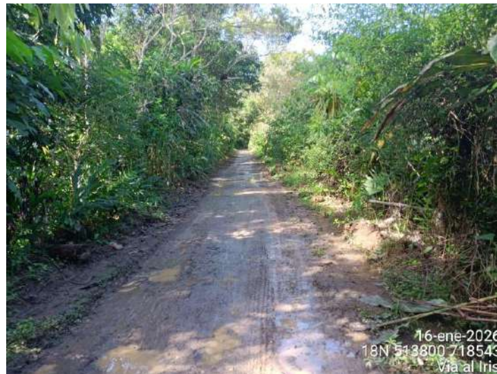
Fotografía 3.11 Vía quebrada La Palestina
