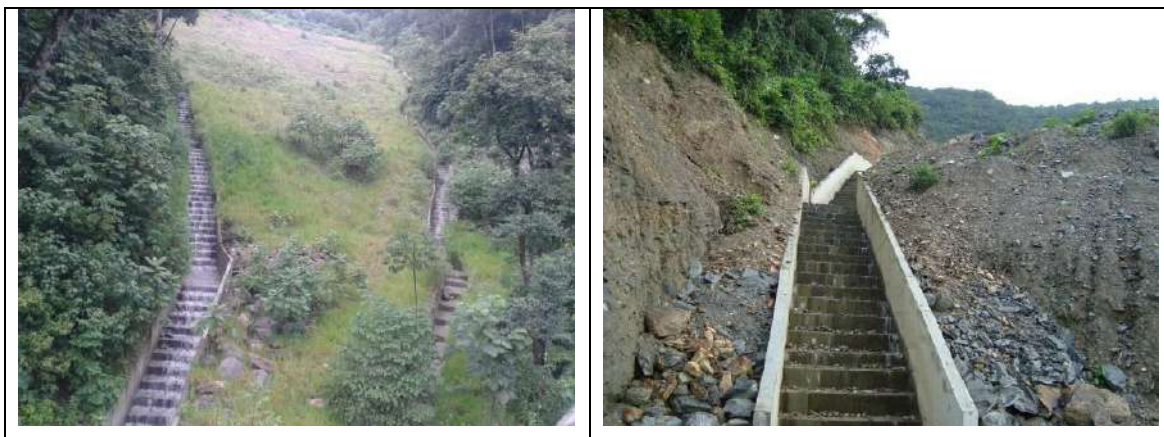
Fotografía 3.16 Canales escalonados en concreto reforzados para depósitos
