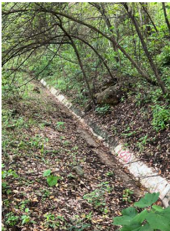
Fotografía 3.17 Cunetas en concreto para las bermas de los depósitos
