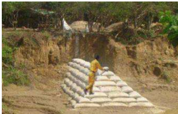
Fotografía 10.1.5 Ejemplo colocación de bolsacreto para control de socavación en la pata del talud.
