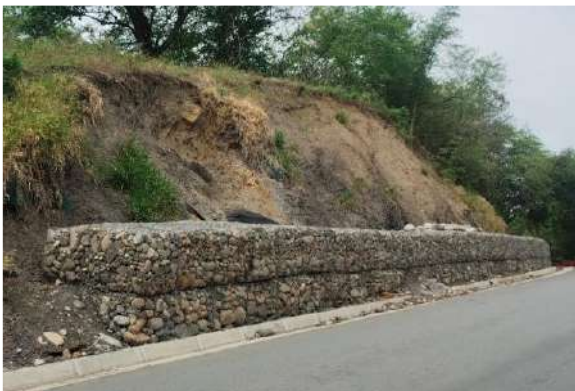
Figura 10.1.5 Muros de gravedad: gaviones (izquierda) contrafuerte (derecha)
