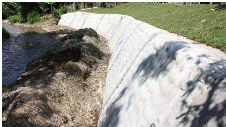
Fotografía 10.1.7 Ejemplo de flexocretos (Dosquebradas Risaralda).
