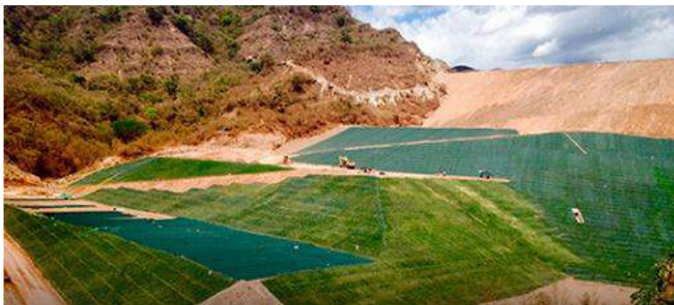
Fotografía 10.1.2 Ejemplos de revegetalización de un talud para control de erosión combinando mantos e hidrosiembra.
