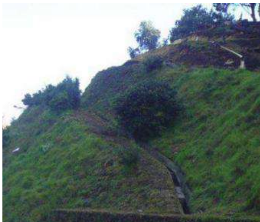
Fotografía 10.1.4 Ejemplo ronda de coronación en taludes.
