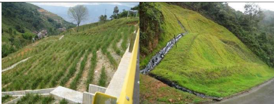
Fotografía 10.1.1 Ejemplos de revegetalización de un talud para control de erosión con siempre de especies.
