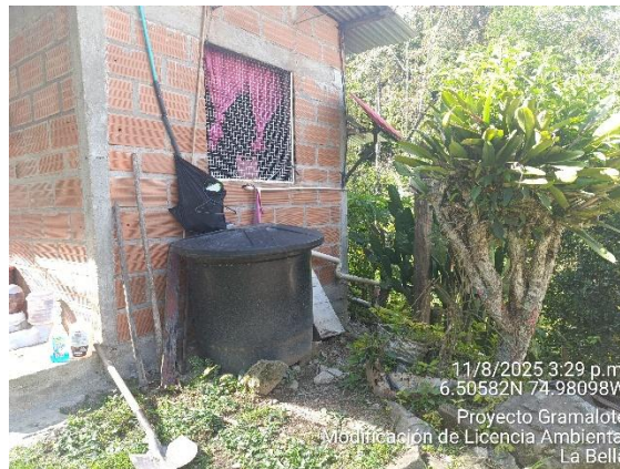
Fotografía 5.4.1 Tanques de almacenamiento y abastecimiento en las viviendas
