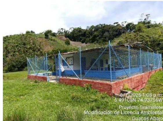
Caseta comunal – Guacas Abajo
