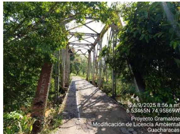
Puente en vía interna, vereda Guacharacas
