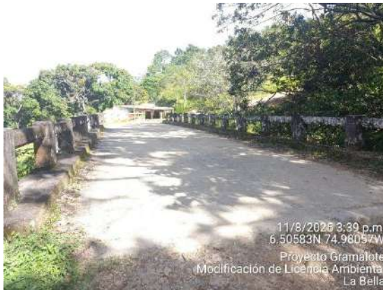
Puente en vía interna, vereda La Bella
