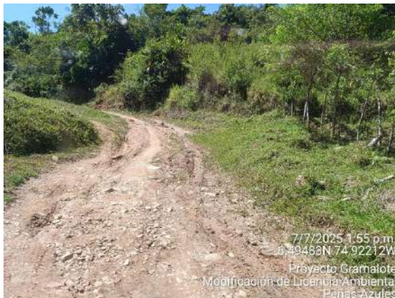
Vía interna, vereda Peñas Azules
