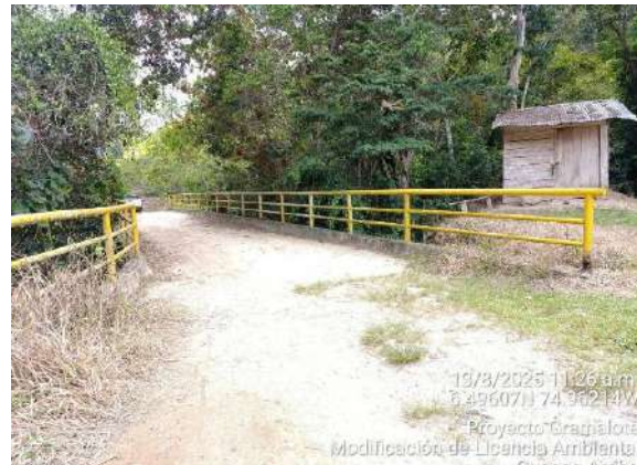
Pontón en vía interna, vereda Guacas Arriba
