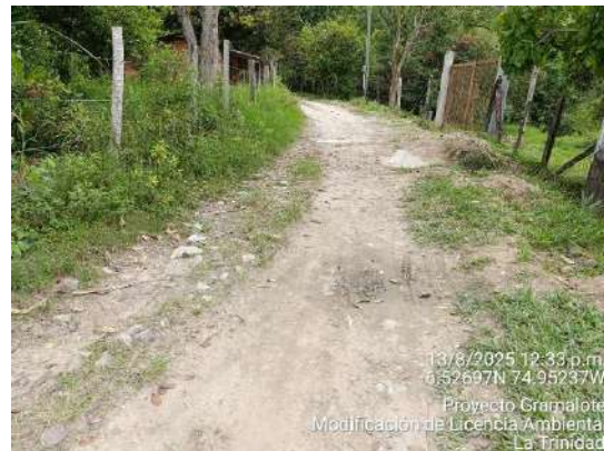
Vía interna, vereda La Trinidad
