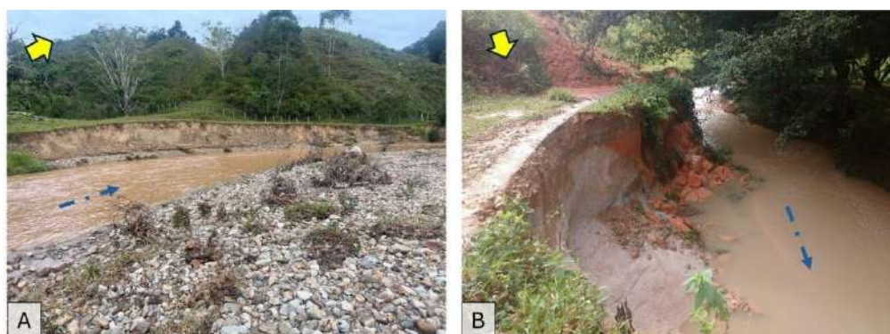
Fotografía 5.5 Socavación de orillas en quebradas tributarias del río Nus. A. Erosión lateral en la margen izquierda de la quebrada Guacas, B. Erosión lateral en la margen derecha de la quebrada El Topacio
