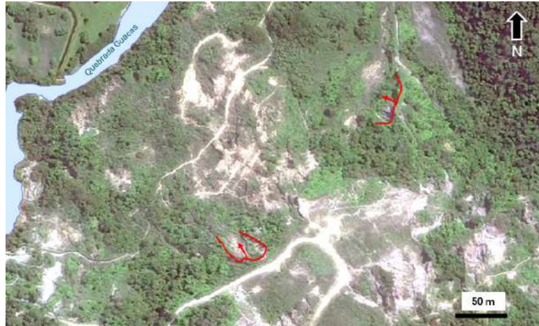
Figura 5.1.7.5 Deslizamiento activo en las inmediaciones de la quebrada Guacas, margen derecha (Imagen satelital del año 2023)
