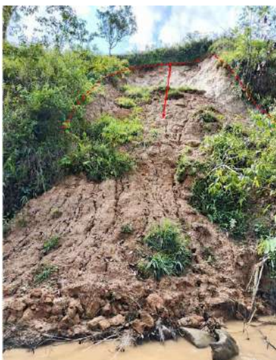
Fotografía 5.1 Deslizamiento activo en la vereda El Iris
