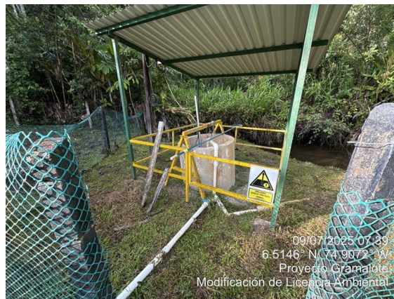
Fotografía 5.1.5.2.2 Aljibe proyecto Gramalote – La Mayoría
