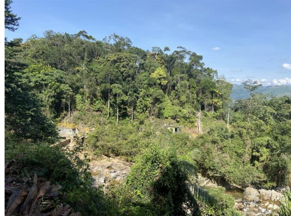
PCH La Cascada
