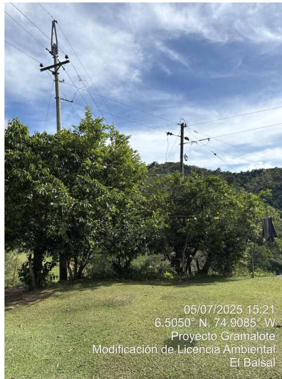
Fotografía 5.1.3.23 Líneas de energía presentes en el área de influencia de paisaje Coordenadas Magna Sirgas Origen Nacional E: 4.789.040,60 N: 2.277.192,90 Fuente: Integral S.A., 2025
