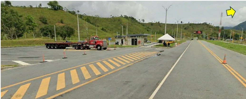
Fotografía 5.1.2.7 Superficies de explanación (Asp) en la vía de Barbosa – Puerto Berrío
