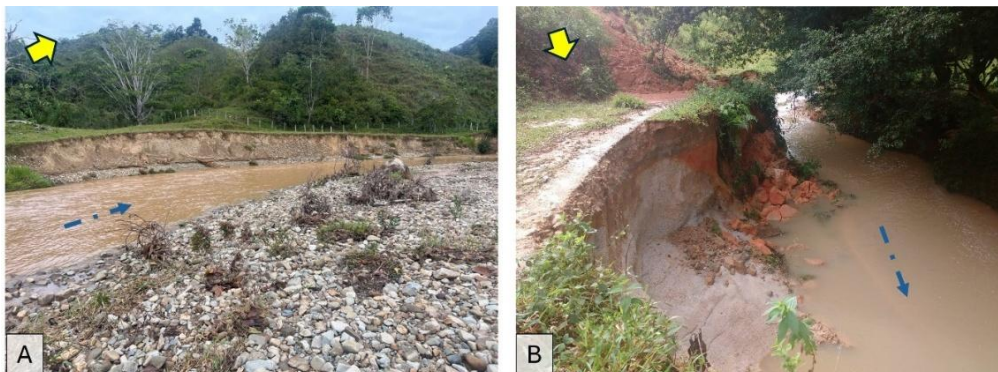
Fotografía 5.1.2.12 Socavación de orillas en quebradas tributarias del río Nus. A. Erosión lateral en la margen izquierda de la quebrada Guacas, B. Erosión lateral en la margen derecha de la quebrada El Topacio
