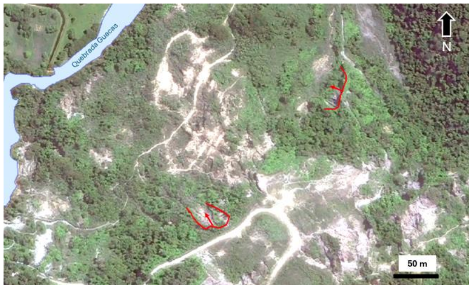
Figura 5.1.2.7 Deslizamiento activo en las inmediaciones de la quebrada Guacas, margen derecha (Imagen satelital del año 2023)
