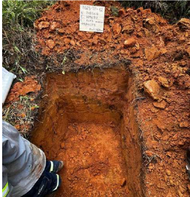
Fotografía 5.1.1.5 Perfil de meteorización del Batolito Antioqueño (sapolito). Apique donde se observa el horizonte del grado V del perfil de meteorización
