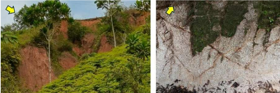
Fotografía 5.1.1.1 Unidad litológica correspondiente al Batolito Antioqueño. Izquierda: Horizonte de meteorización de suelo residual (VI). Derecha: Horizonte de meteorización de saprolito (V)
