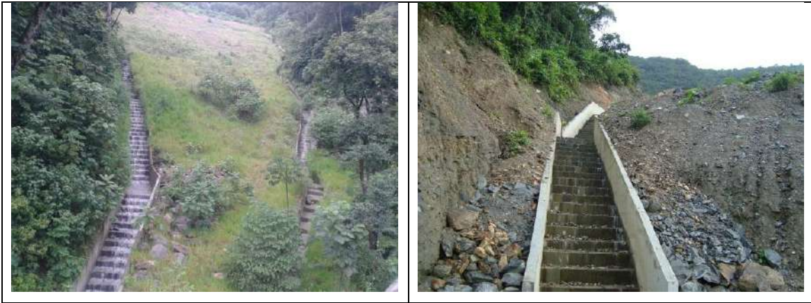
Fotografía 3.16 Canales escalonados en concreto reforzados para depósitos Fuente: Integral S.A.
