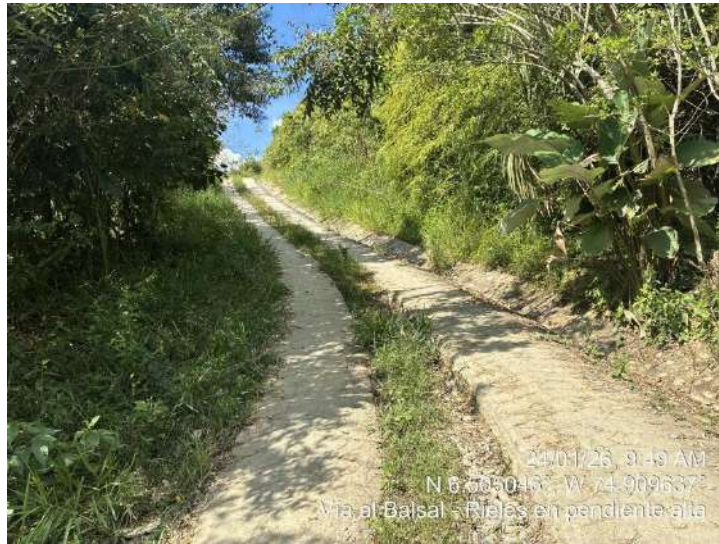
Fotografía 3.3 Vía a El Balsal, rieles en pendiente alta Fuente: Gramalote Colombia Limited, 2025.
