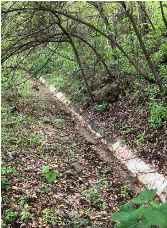
Fotografía 3.17 Cunetas en concreto para las bermas de los depósitos Fuente: Integral S.A.
