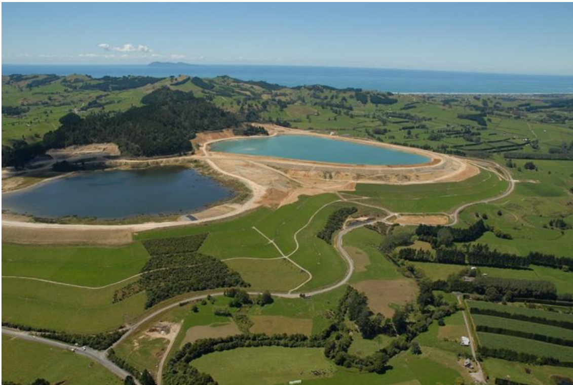
Fotografía 10.1.4.1 Imagen de Referencia. Presa de relaves rehabilitada, luego de varios años después del cierre de la mina
